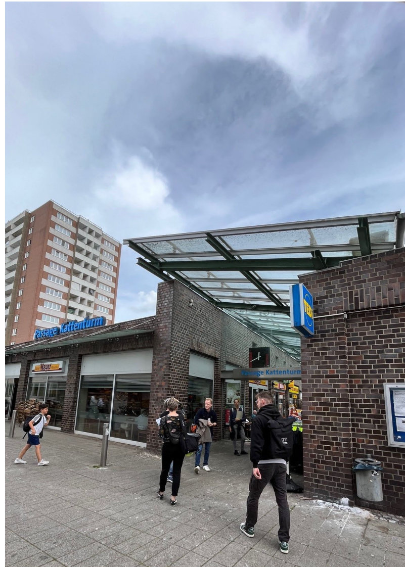
Eingang Passage Kattenturm
